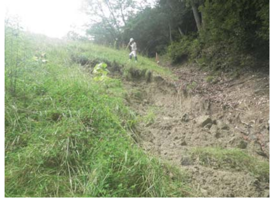
8. 小池 (広島県・福山市) 取水施設側堤体下流より左岸側を望む
