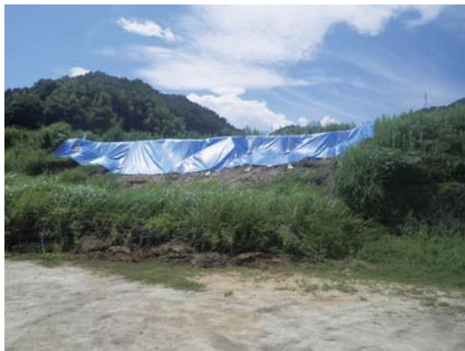
9. 半三池 (広島県・竹原市) 堤体崩壊部 (下流より望む)
