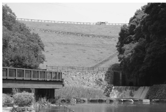
写真-4 円弧状の堤体
