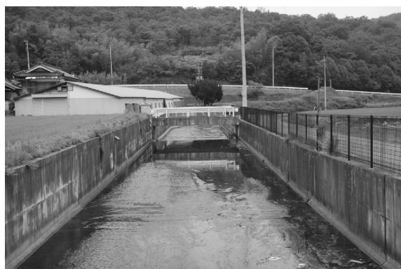
写真-3 天川導水路
