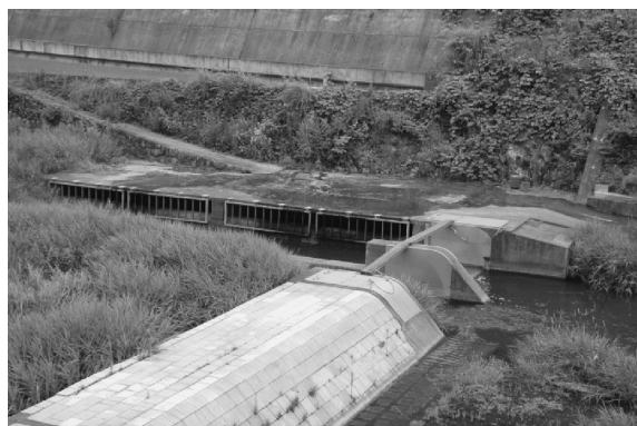
写真-2 天川頭首工
