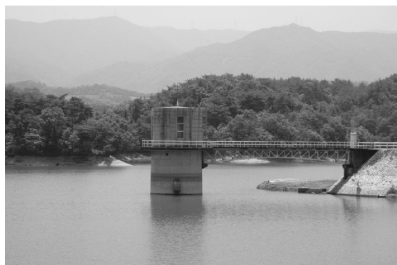
写真-1 現在の取水塔
