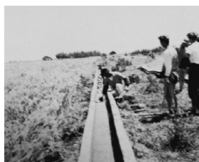
写真-4 出役での小水路造り
