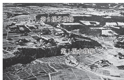
写真-1 第一機場・第二機場回りから三方原台地を望む
