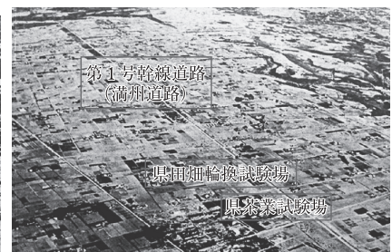
写真-2 三方原工区の全景
