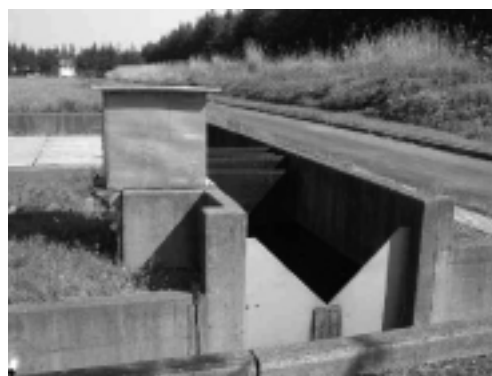
写真5 堰による流量観測施設
