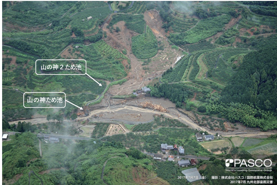
6. 山の神2ため池の背後地山の2カ所が大きく崩壊し、土砂がため池に流入（福岡県朝倉市）
