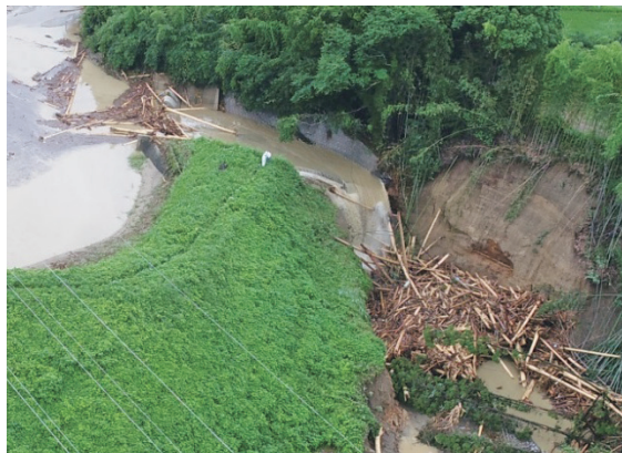
2. 洪水吐左岸側下流の地山が崩壊
