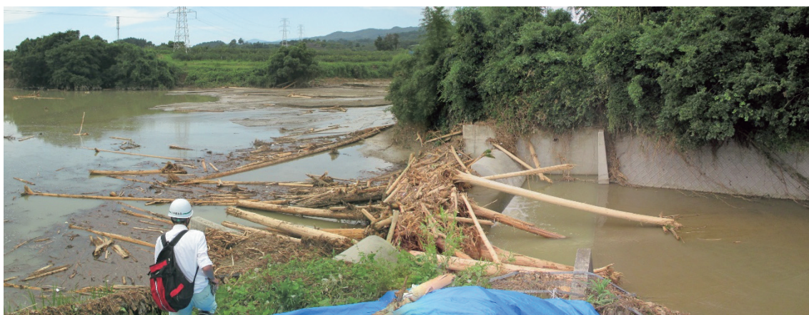
5. 鎌塚ため池の洪水吐と貯水敷（堤体が決壊しなかったことで貯水池内に土砂と流木が多くとどまっており、下流での流木被害を軽減したと考えられる）
