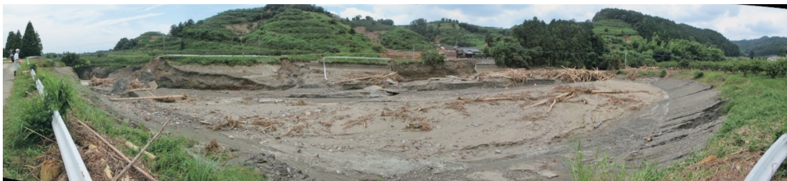
7. 山の神ため池の貯水池（左岸地山より貯水池を望む。流入した土石流はほとんど堆積していない）
