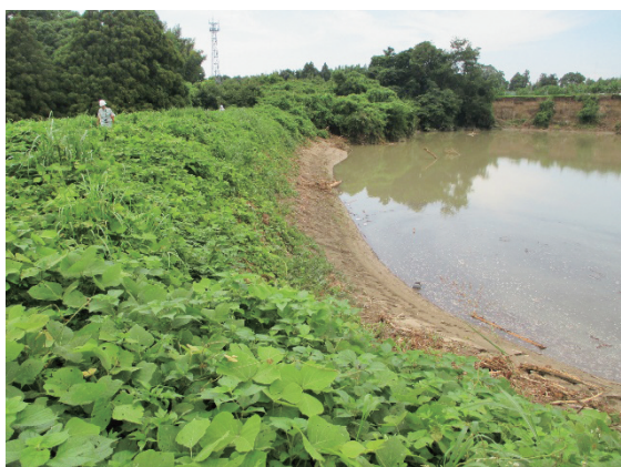
3. 堤体天端と貯水池（越流はしていない。堤体天端から 1.0 m 下がりまで貯水位が上昇）
