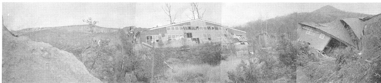
写真-1 噴火口近くの建物の被害状況（隆起，陥没などの地殻変動により建物が破壊された。左側の松の木は町道泉公園線の街路樹。道路は原形がわからないほど変形）
