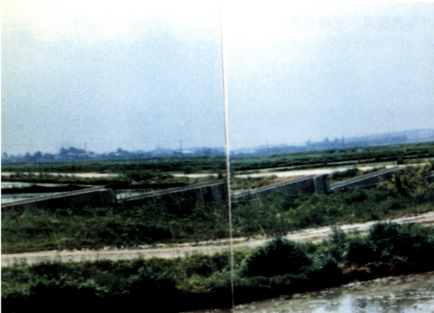
掛樋の脱落（青森県木造町，写真提供：西土地改良事務所）
