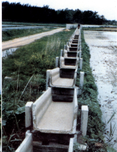
掛樋の脱落（青森県木造町，写真提供：西土地改良事務所）
