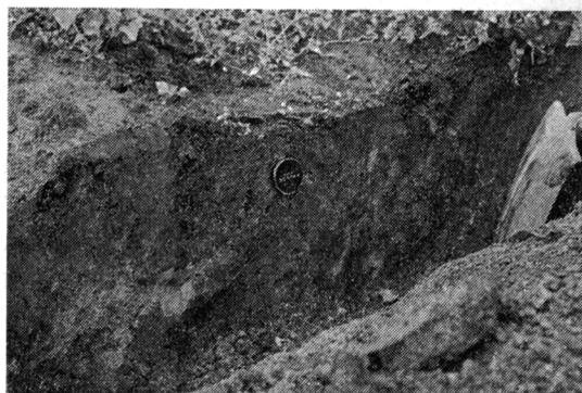
写真-1 復旧工事後の噴出物と旧作土の混合状況
