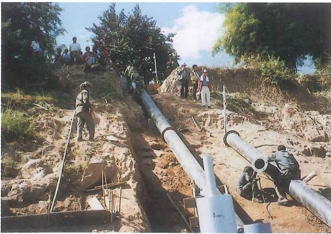
ラオスウットゥムカオ 灌漑プロジェクト 揚水管設置作業 (写真提供：三苦英太郎)
