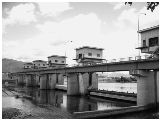
写真-1 牟呂松原頭首工
