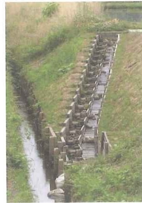
試験結果を利用した施工のイメージ (写真：兵庫県 三江地区)
