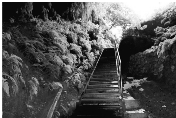
写真-3 住吉暗川の地下へ降りる急傾斜の通路
