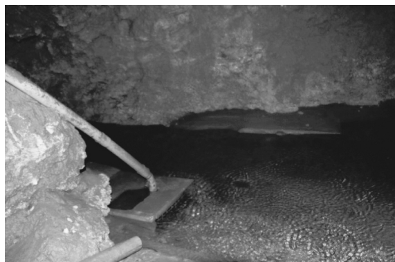
写真-4 住吉暗川の内部
