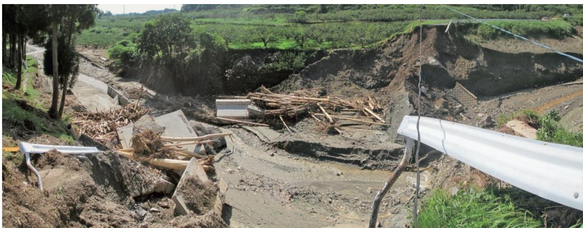
8. 山の神ため池の決壊した堤体部 (右岸アバットから堤体決壊部を望む)
