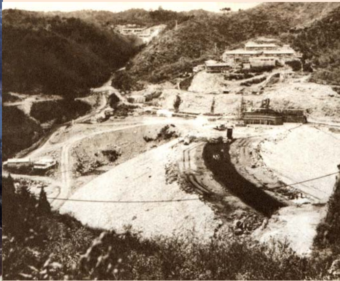
日出生(ひじゅう)ダム
