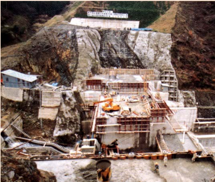
布喜川調整池 (工事中)
