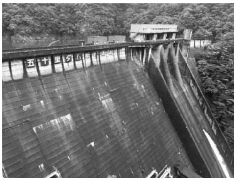
写真-1 五十里ダム
