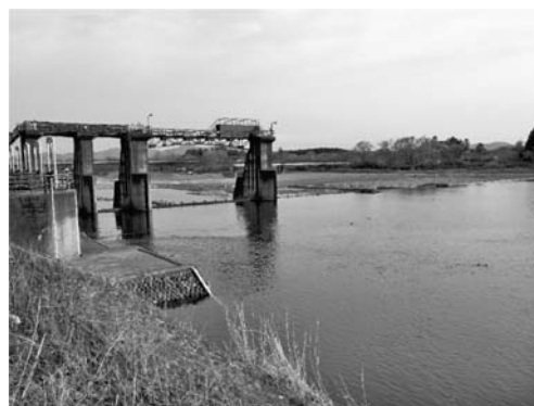
写真-2 佐貫頭首工（上流左岸より望む）
