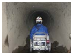
■管内走行状況
