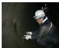
■電磁誘導法の測定状況
