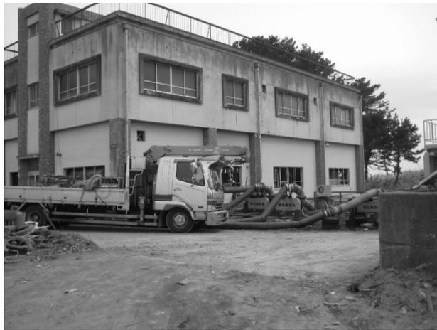
写真 1 損壊した排水機場と湛水排除のための災害応急ポンプ
