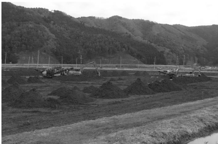
写真4 自走式石礫選別機による小がれきの処理 (2012.12.14 (宮城県石巻市))
