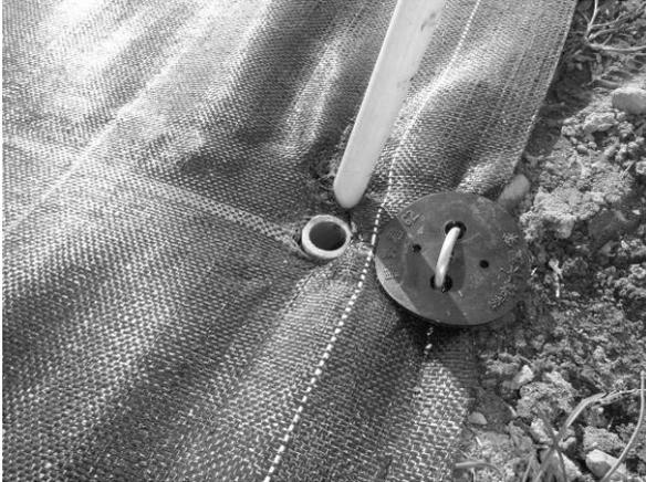
扉にする部分は、塩ビのパイプを35cm程度に切断し、地面に打ち込む。
