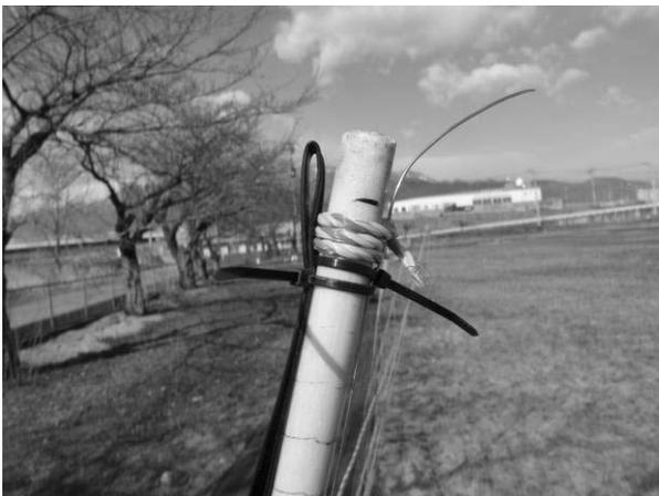
まず柵の外側に、支柱に沿って針金を設置する(写真右)。この針金は支柱の上端から地表 20cm くらいまでとし、決して地面に接触させない。マイナス線は、支柱に直接固定せず、マイカ線を二重にした絶縁用の帯の上に固定する。このマイカ線は地表に接触しても差し支えない。
