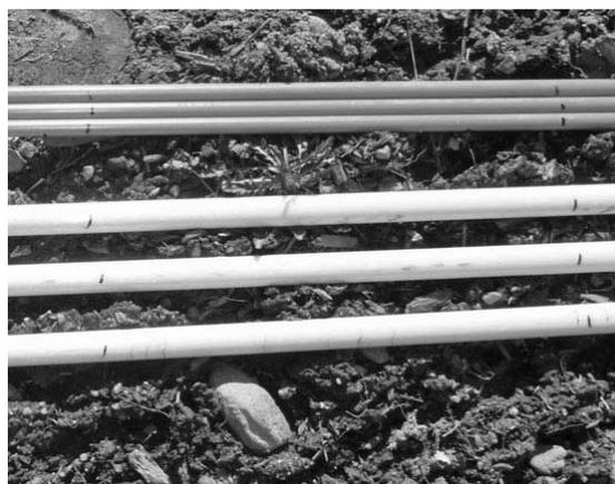
電線固定部分の印をつけた支柱を 2.5m 間隔、深さ 35cm で打ち込む。防草シートを用いる場合にはシート端から 10cm 内側に支柱を打ち込む。
