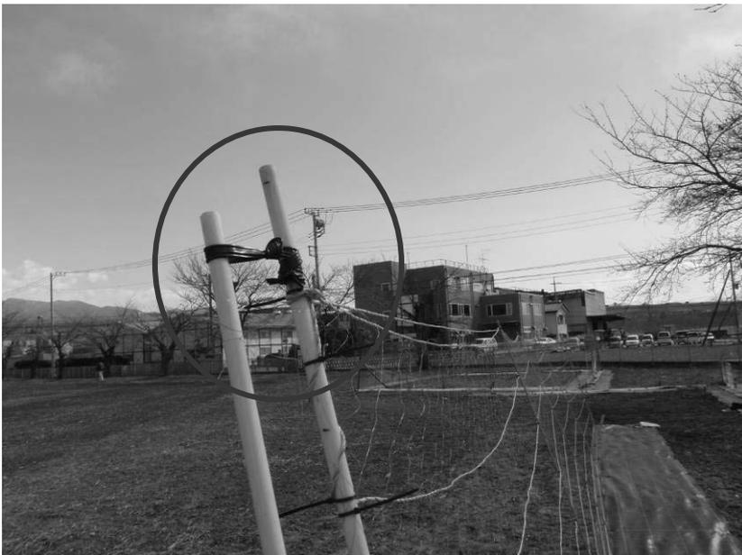
出入り口の扉は、この写真のように支柱同士を簡単に縛る、または輪をひっかけるだけでよい。扉を開くときにはこのヒモをほどき、支柱ごと塩ビ管から上に引き抜く。この方法を用いることで、支柱に電線を固定したまま扉の開閉が可能となる。
