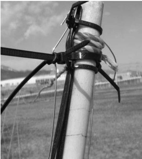
マイナス用の針金は支柱に直接固定せず、太い結束バンドに固定する。固定には細い結束バンドを使う。
