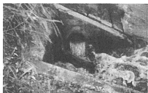
図-14 排水路保護工からの排水（写真正面）
