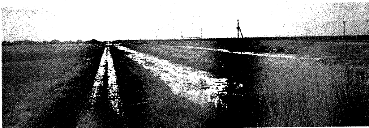
地盤沈下により機能低下した水路
