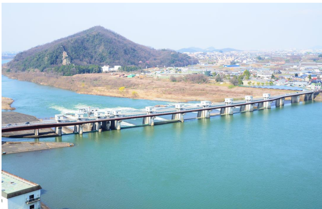
犬山城からのぞむ犬山頭首工
