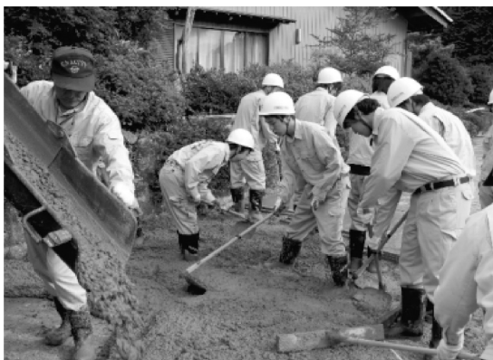
写真-4 農道舗装実習 (コンクリート打設)
