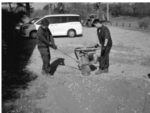
写真-1 総合実習（土木施工班：駐車場におけるランマによる締固め）
