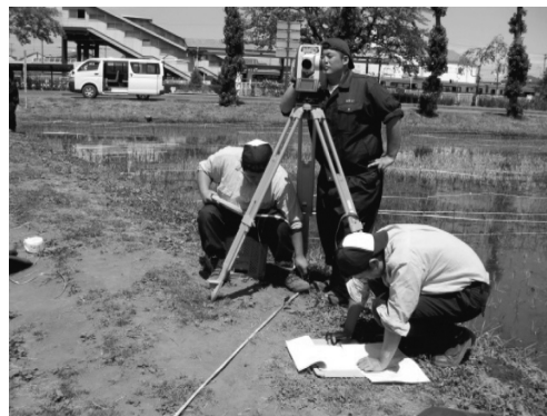
写真-2 総合実習（測量専攻班：田んぼアートでの測点杭打ち）
