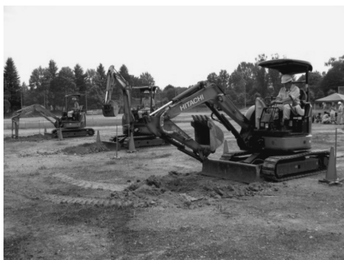
写真-3 小型車両建設機械特別教育講習会での実技講習
