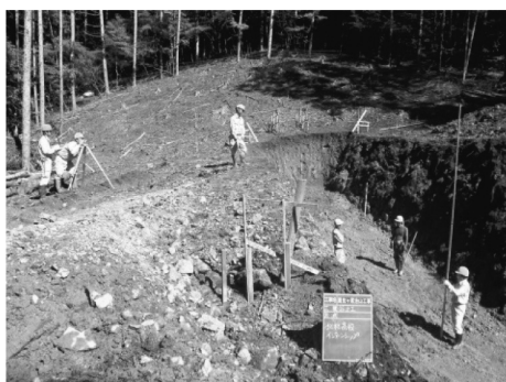
写真-3 現場実習
