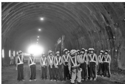
写真-2 トンネル工事の現場見学
