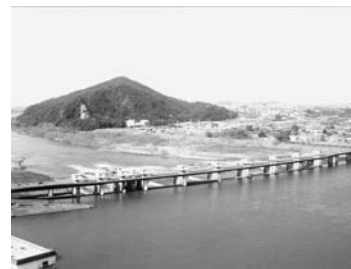
犬山城からのぞむ犬山頭首工
