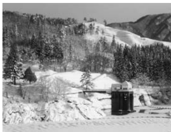
豪雪地で輝く皆瀬ダム取水塔（遠山泰正）
