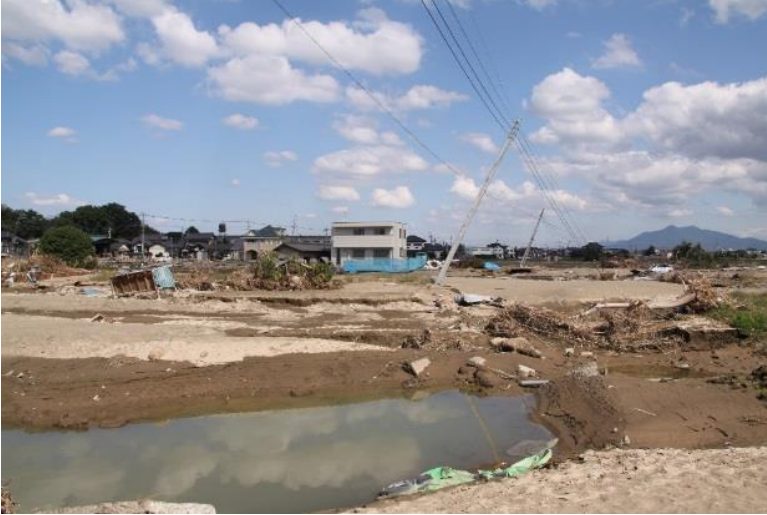
農地の洗掘(堤内)
