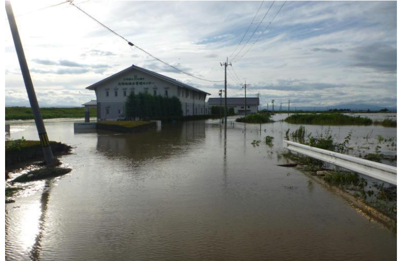
農地の湛水と排水機場の浸水(堤内)
