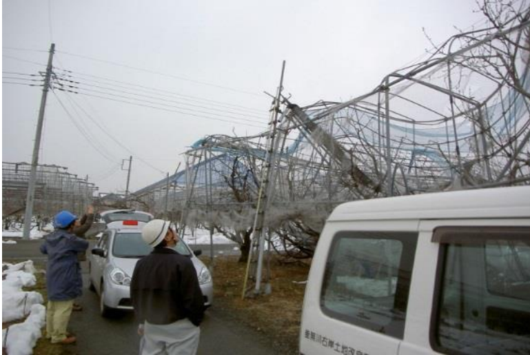
降雪に伴うサクランボ雨よけハウスの破壊
