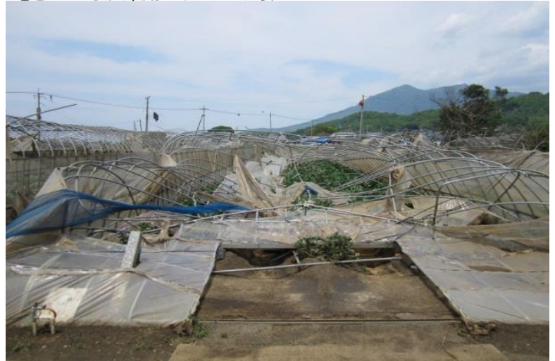
竜巻による農業用ハウスの破壊
