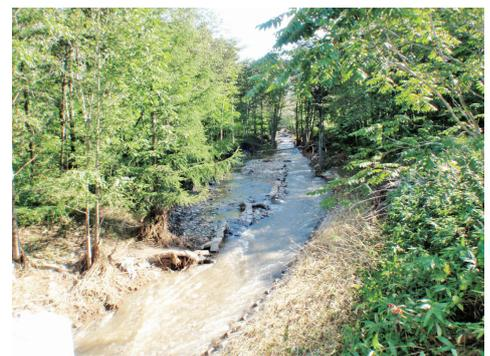
写真-6 連節ブロック背後の法面の侵食（手前が下流。中央に見えるのが右岸の連節ブロック。左岸に水位上昇の跡が見える。）
