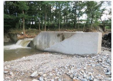
写真-3 むき出しになった落差工のコンクリートブロック（写真-2と同じ地点。白っぽいところまで覆土され、護岸ブロックがあった。）
