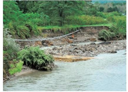
3. 護岸の洗掘によるパイプラインなどの損壊（新得町）
