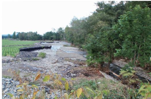
写真-2 排水路の氾濫（排水路は、写真右の林沿いにある。写真右下に、両岸の護岸ブロックが見える。また写真中央に落差工の左岸側コンクリートブロックが見える。）
