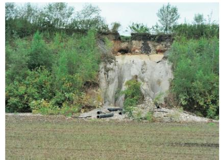
9. 崖の崩落により段丘上の農地の排水施設が損壊（芽室町）
