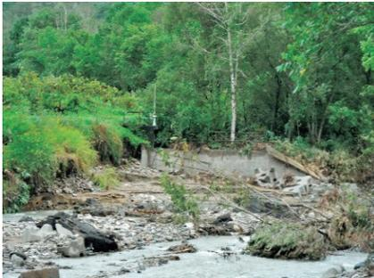
4. 土石流による護岸・落差工の損壊（新得町）
