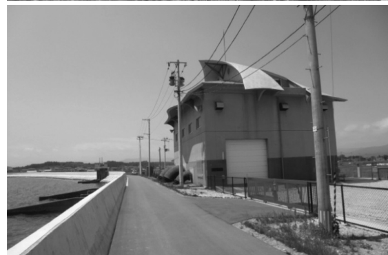
写真-8 上：被災直後，下：復旧した機場 (相馬市・相馬排水機場)
