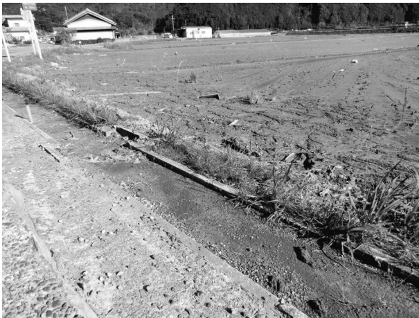
写真-6 洪水土砂による用水路の埋塞（紀宝町大里地区）
