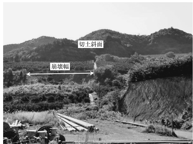
写真-4 農地の地すべりと背面の切土斜面(御浜町志原地区)
