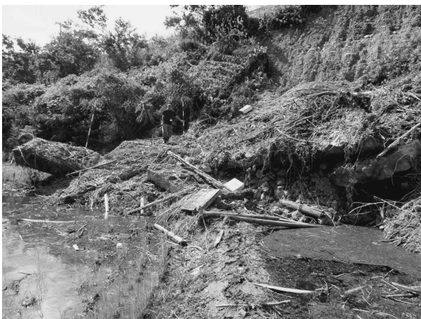
写真-7 斜面崩壊による水路の閉塞（紀宝町提供，紀宝町井内地区）
