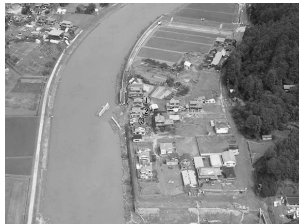
写真-13 高岡地区特殊堤の転倒状況（紀宝町提供、平成 23 年 9 月 5 日 11:05 撮影）
