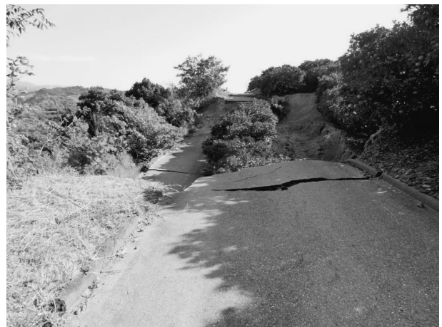
写真-10 農地の地すべりによる農道の寸断（御浜町志原地区）
