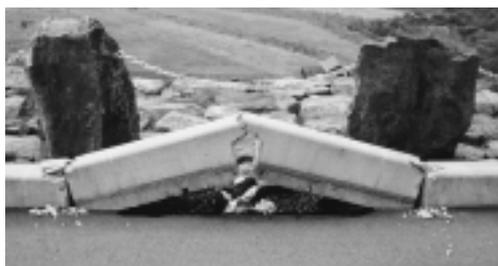
写真 3 縁石コンクリートの屈曲と圧壊
