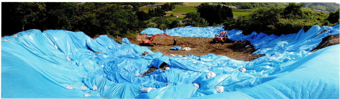
(8)宮城県栗原市築館地区で発生した地すべり—崩れ落ちた土塊の形状がシートに残っている—
