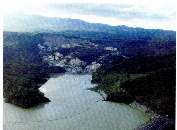
(3) 上空から見た左岸上流の地すべり—向かって左側の北西より南東方向に移動し、末端は対岸に乗り上げたと思われる—
