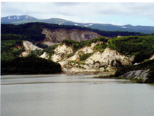
(2) 荒砥沢ダム（宮城県栗原市）から見た左岸上流の地すべり
