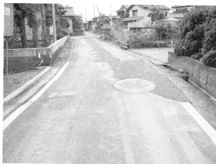
写真-4 刈羽村赤田における集落排水施設の応急復工事後の様子(2007年7月22日撮影)
