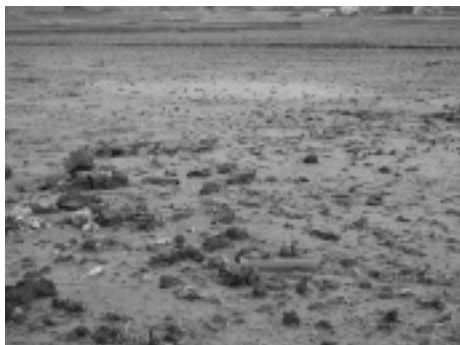
写真8 暗渠管の噴出・散乱
