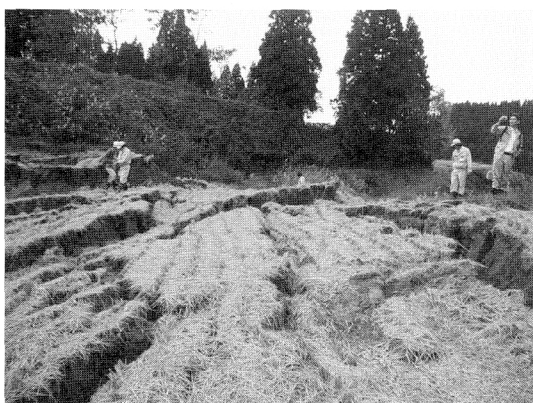
写真-2 地すべりを起こした柵田の被害調査 (旧栃尾市)
