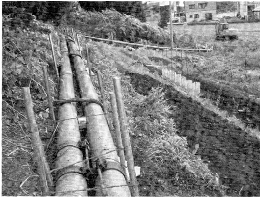
写真-1 川口町相川地区の応急送水管
