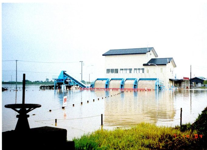
洪水の中孤立した大沼排水機場（中之島町） （写真提供：新潟県農地部）
