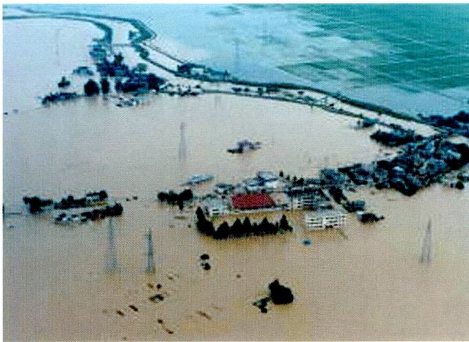
猿橋川の破堤による氾濫（長岡市）（写真提供：新潟県農地部）
