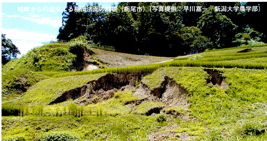
崩壊した土砂が水田まで押し出されている（栃尾市）（写真提供：稲葉一成）
