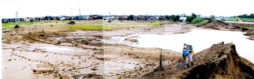
五十嵐川左岸堤防の決壊（曲渕地内）（写真提供：新潟大学積雪地災害センター）
