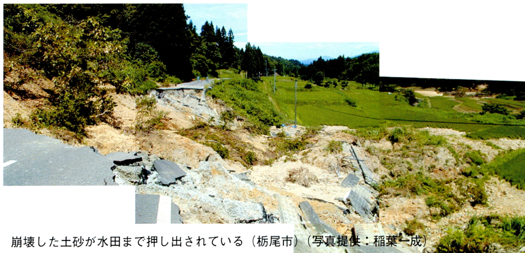
畦畔からの溢水による棚田法面の崩壊（栃尾市）（写真提供：早川嘉一 新潟大学農学部）
