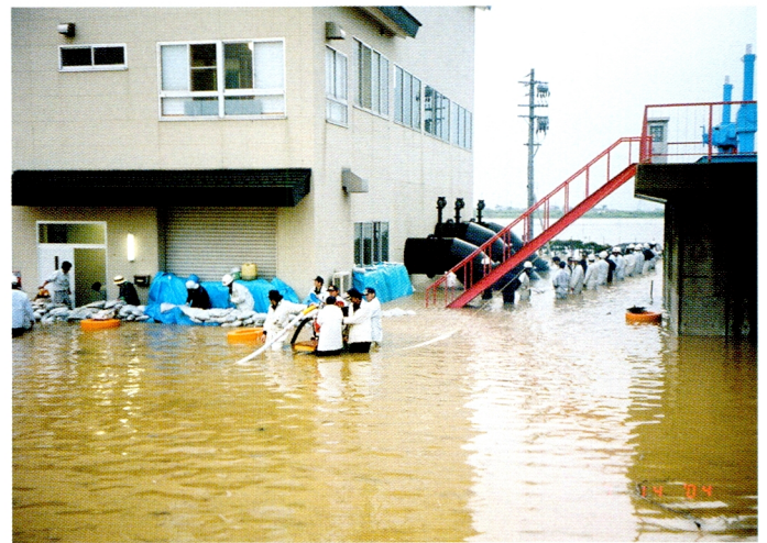
土嚢で浸水を防ぎながら昼夜フル運転を続けた大沼排水機場 （写真提供：新潟県農地部）
