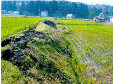
8. 震源地近くの農地で崩壊した畦畔、遠景の住宅は倒壊して痛々しい、傾斜は1/15程度（川口町田麦山周辺）
