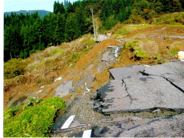
2. 路盤から滑落した山間地集落へのアクセス用幹線道路（小千谷市川井周辺）
