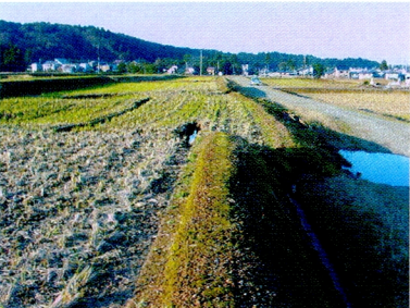
7. 亀裂段差を起こし、先端は農道にせり出している、農道もこれに連動して亀裂段差を起こし、破壊されている、比較的平坦で、傾斜は1/50程度（小千谷市両新田周辺）
