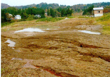
11. 原形をとどめない養鯉池、堤防は亀裂段差を生じ、池底より低くなった、池底には亀裂が走る（川口町武道窪周辺）
