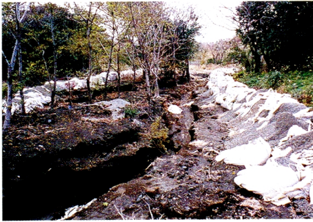
5. 溪流を流下する泥流の農地等への侵入を防止するために土嚢で作られた流路工
