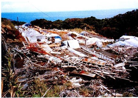
7. 土石流と降灰で押し潰されたビニルハウス群
