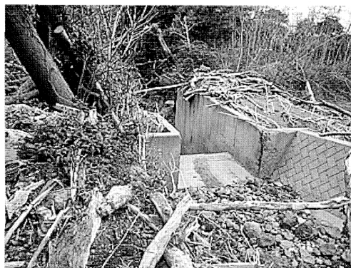
写真-4 西原ダム周辺。取水口やその周辺水路は、大型の土砂に埋没しているため、将来の降雨による土砂の流出の危険がある
