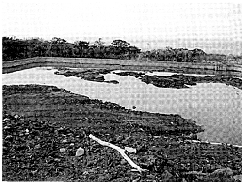
写真-3 神着ダム。火山灰や土砂の流入が見られた。このダムでは、排泥作業が進むと同時に、上流に砂防ダムの建設が進んでいた
