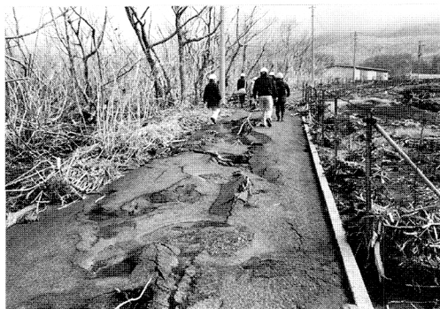
写真-1 牧場内道路。村営牧場は1m程度の堆積があり、巨礫を含む火山礫と降灰が見られ壊滅的な状況
