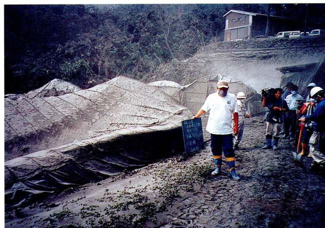
3. 火山灰の重みにより変形・倒壊したビニールハウス
