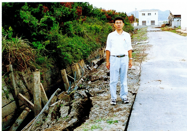
4. 破壊した潮廻し（弓浜）（米子地方農林振興局提供）
