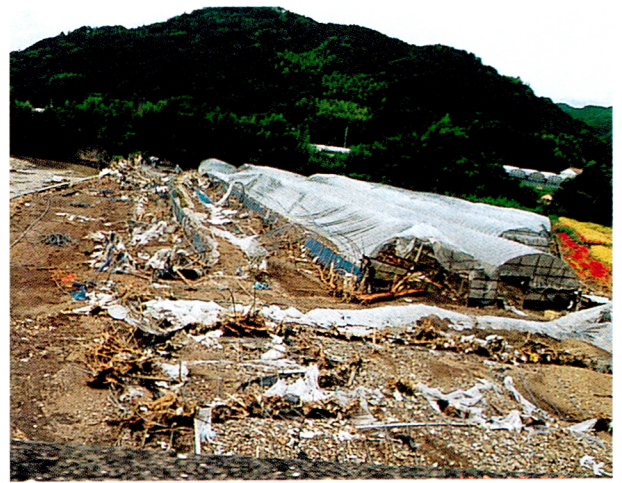
9. 濁流により倒壊したパイプハウス（高知県土佐山田町新改、高知県農林水産部提供）
