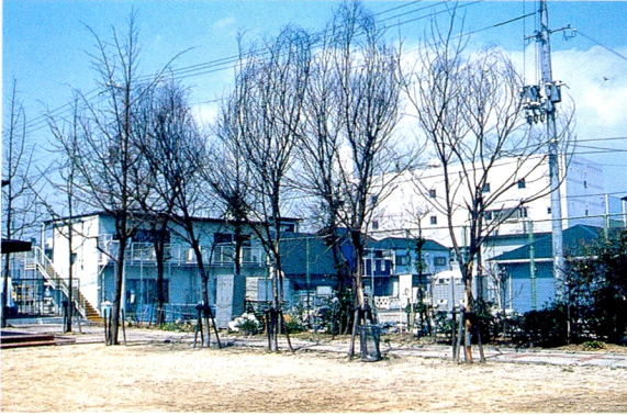
公園緑地の被災状況（新長田公園，1996年4月撮影） 公園の周辺が焼失したため，すべての樹木で焼失の程度はきわめて大きく，樹勢の回復も進んでいない。
