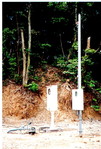
淡路島水源対策工事 完成した揚水機場
