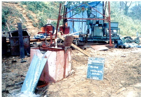
淡路島水源対策工事 揚水試験状況
