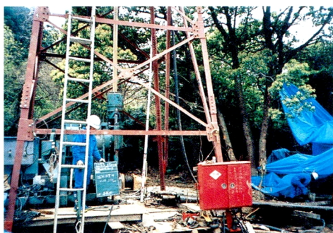
淡路島水源対策工事 深井戸掘削状況
