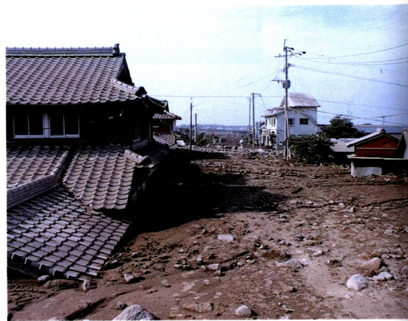
広域農道 河川より島原側広域農道を望む（土石流）
