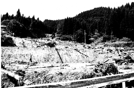
写真-2 棚田の崩壊
