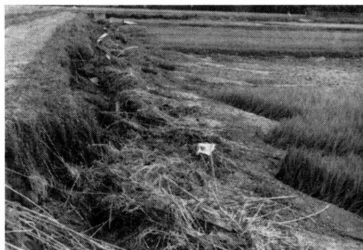
写真-4 横連絡道路下流路肩の洗掘と下流水田への土砂流入 (茂木町)
