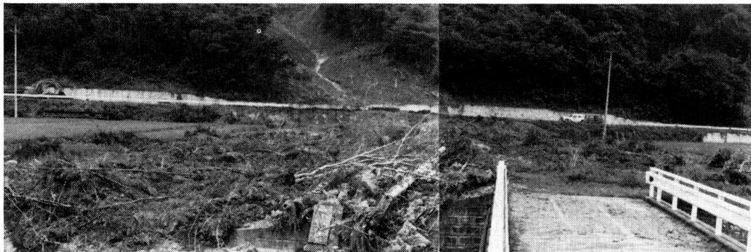
写真-1 斜面崩壊と農地への土砂流入 (南那須町)
