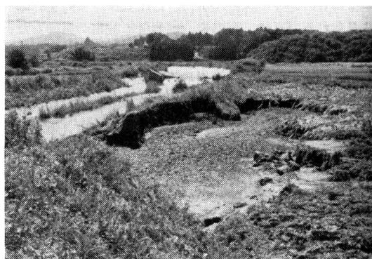
写真-5 越水の河道への再流出地点の後退侵食と農地の流亡 (茂木町)
