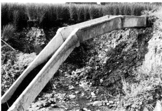
写真-3 高段差畦畔の崩壊と下流水田への土砂流出, ライニング水路のみ残る (南那須町)
