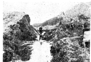
寫眞第 10 底樋管位置の缺潰 五里合村中石溜池
