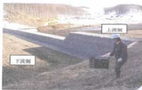
写真-41.2 沈砂池設置状況
