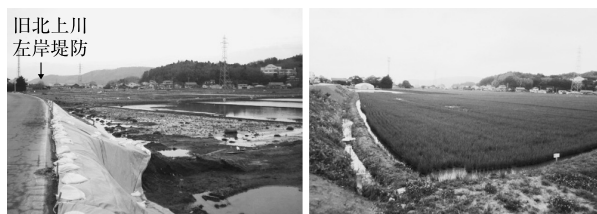
写真-2 被災直後状況・復旧後状況 (平成 24 年作付け)
