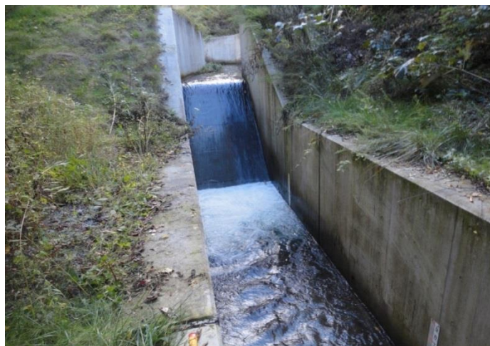
図-1 長野県佐久郡軽井沢町に設置された直角 V 字型減勢工
