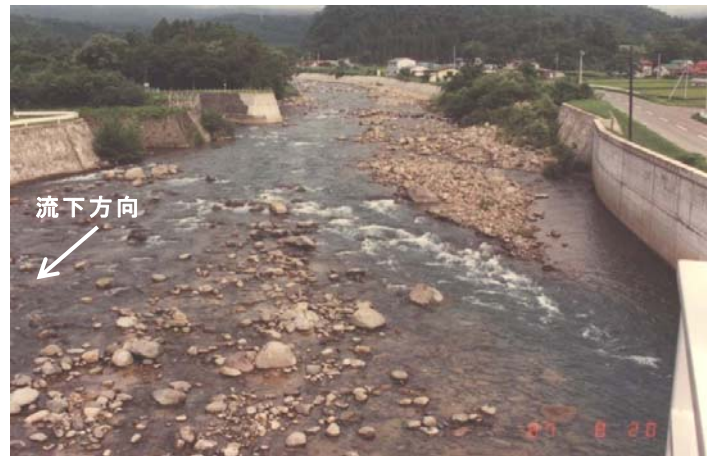
Fig. 7 篠ヶ川原頭首工建設当初における上流側の堆砂状況（1987年8月20日撮影）
