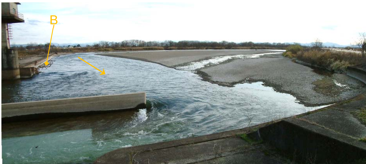
図－４ 山城堰頭首工（秋田県雄物川，横手市）上流の導水路自然形成
