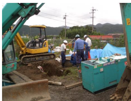
写真-2 補修工事（掘削状況）
