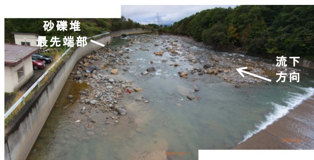
Fig. 6 台風18号による出水後の篠ヶ川原頭首工砂礫堆形成状況(下流側, 2013年10月7日撮影)
