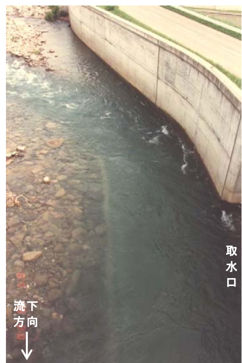
Fig. 8 篠ヶ川原頭首工建設当初における上流側の土砂吐水路（1987年8月20日撮影）
