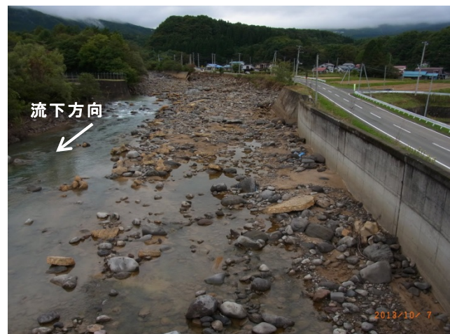
Fig. 5 台風18号による出水後の篠ヶ川原頭首工砂礫堆形成状況(上流側, 2013年10月7日撮影)
