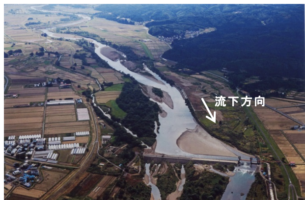
Fig.10 山城堰頭首工付近における砂礫堆と固定堰に沿う流れの形成状況 （提供：湯沢河川国道事務所，2007 年撮影）
