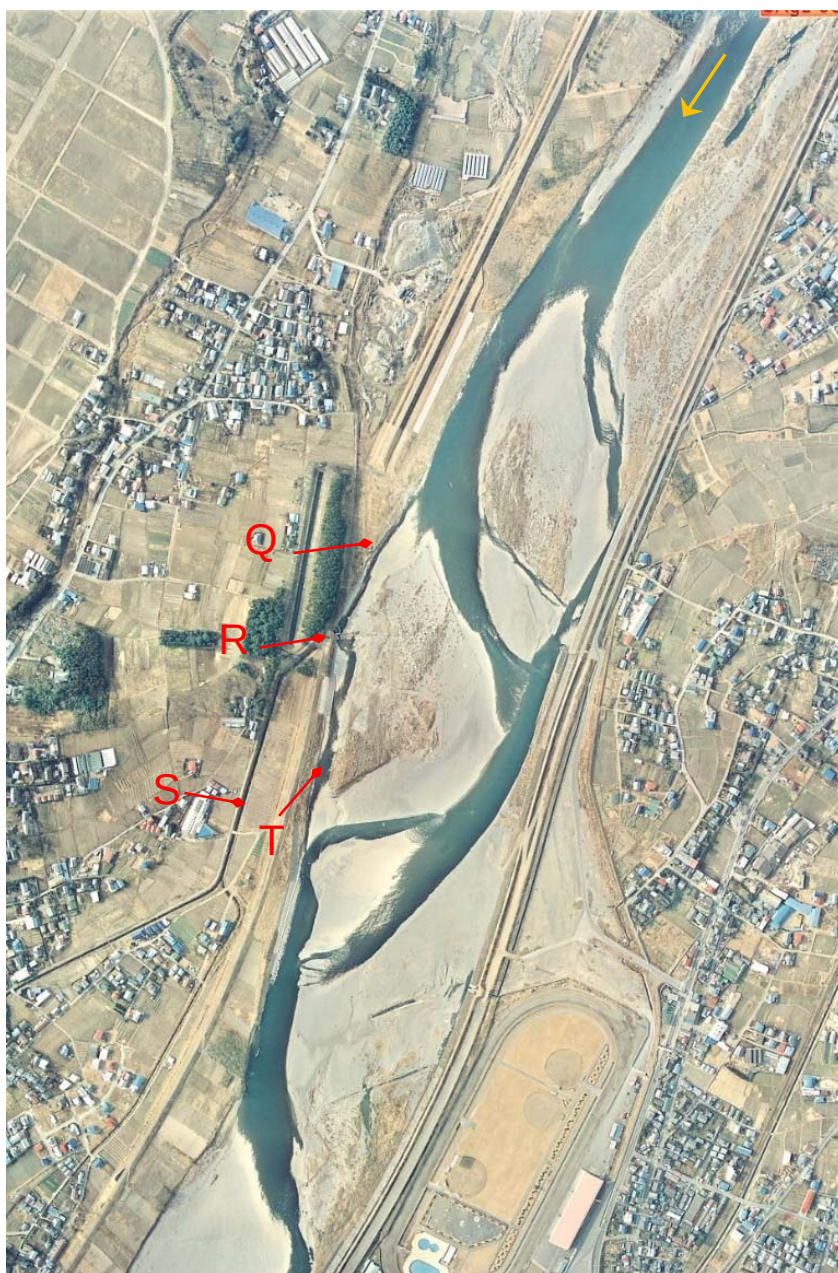
図-14 渡良瀬川筋旧待矢場堰（群馬県太田市）における取水口の閉塞と臨時導水路掘削
