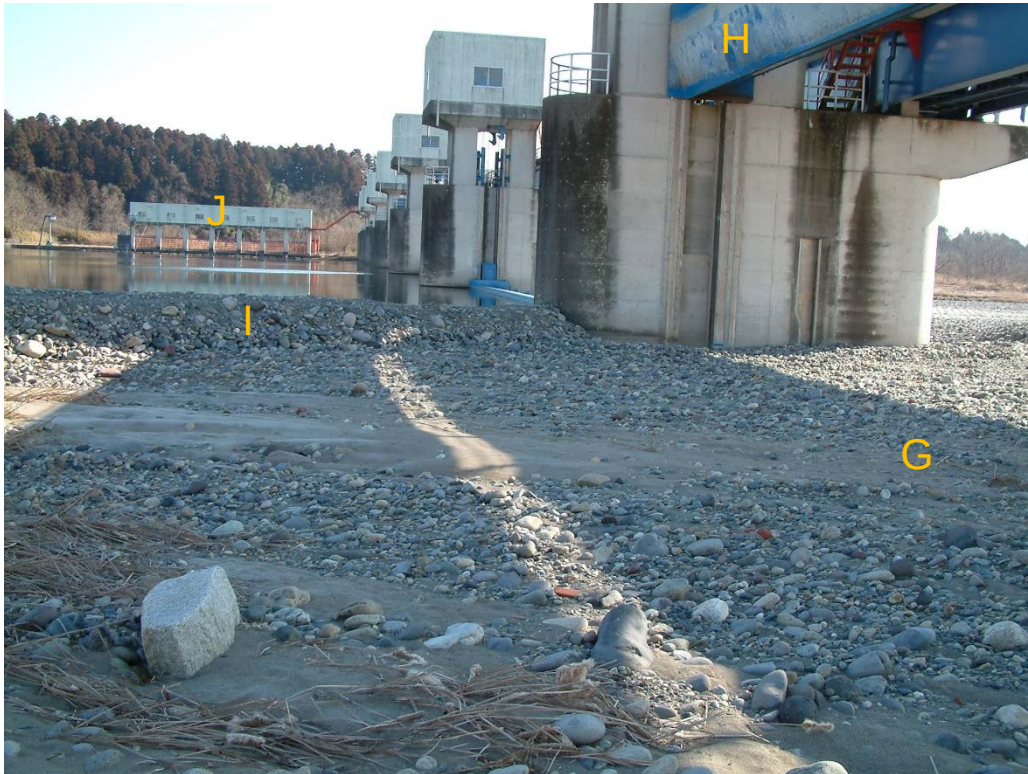
図－8 岡本頭首工（栃木県鬼怒川）におけるゲート吊り上げと仮設砂利堤による取水態勢
