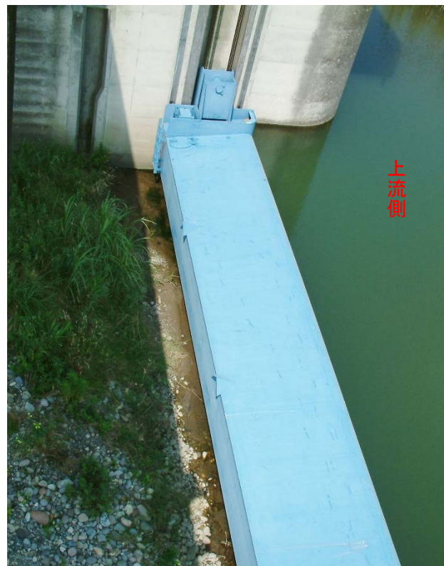
図－15 岡本頭首工 6号洪水吐ゲートにおいて堆砂除去によってゲート閉鎖した状態（2010年7月28日撮影）
