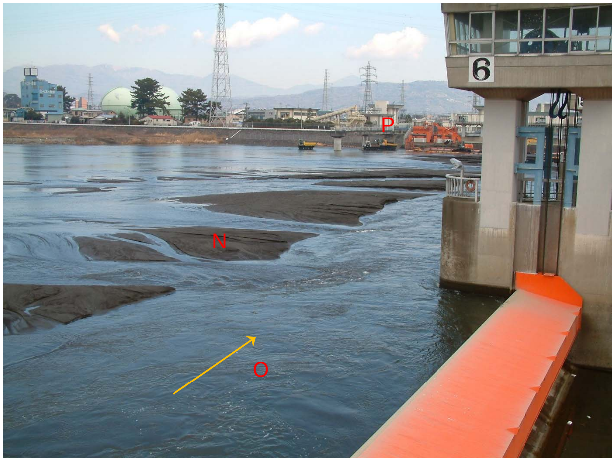
図-13 飯泉取水堰（神奈川県酒匂川，小田原市）上流の H. 22. 09 洪水後の堆砂状況
